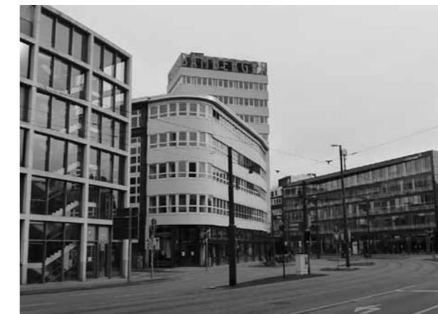
Was Umbau bewirken kann: VHS und Radio Bremen beleben Faulenquartier und Stephaniviertel
